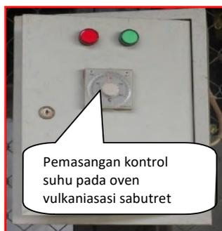
Gambar 2 pemasangan dan peletakan kontrol suhu pada box panel proteksi.
